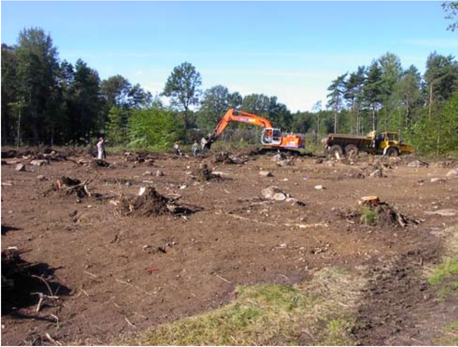
Fig 11. Schaktning av undersökningsområdet. Foto mot sydväst.
